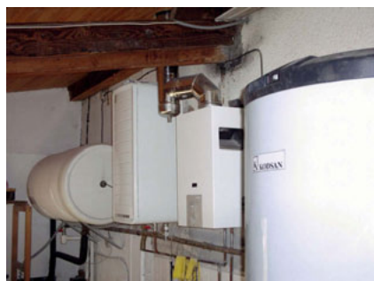
Figure 7.3 De gauche à droite, le ballon d'eau chaude sanitaire, l'eau chaude sanitaire électrique, le chauffe-eau gaz.
