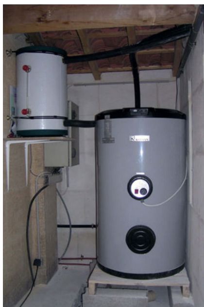
Figure 3.2 Exemple d'installation autovidangeable : le ballon blanc, en haut à gauche de l'image, permet de vider le circuit des capteurs.
