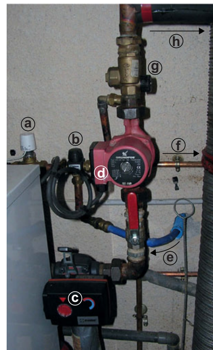
Figure 9.16 Circuit du départ vers les radiateurs. (a) V3ECS. (b) VTH1. (c) V3R. (d) C4. (e) Eau froide VTH1. (f) Départ ECS. (g) AR. (h) Départ vers radiateurs.
