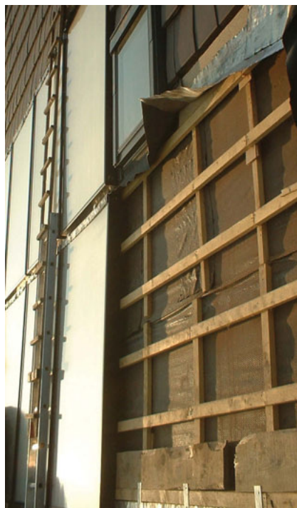
Figure 10.9 L'encoche des panneaux se glisse dans les crochets.
