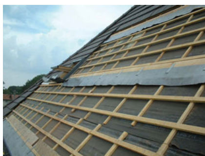
Figure 10.8 Les supports et les bandes de plomb.
