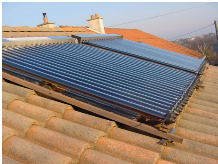
Figure 8.22 L'alignement des deux capteurs n'est pas parfait : les deux encadrements sont légèrement différents car le second a été acheté plus d'un an plus tard.
