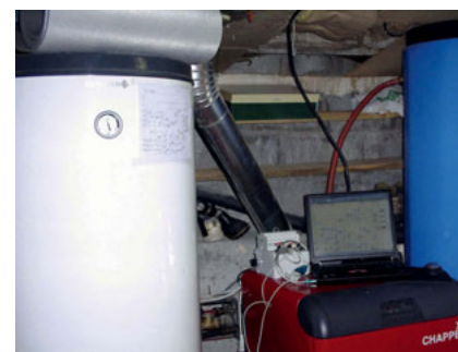
Figure 6.15 De gauche à droite : le ballon d'eau chaude sanitaire, l'API et l'ordinateur portable posés sur la chaudière.
