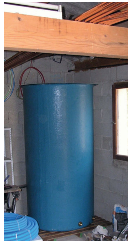
Figure 9.28 La cuve pour le tampon.
