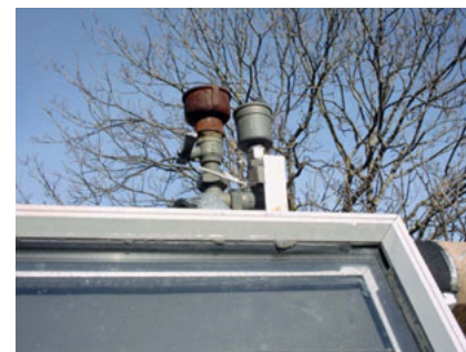
Figure 6.14 Remplissage, vanne d'arrêt, purgeur.
