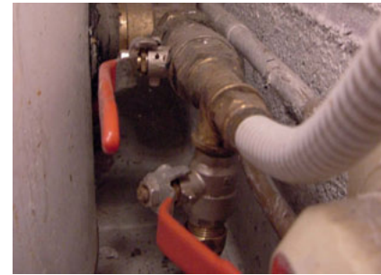
Figure 8.17 Le tube recuit 8/10 est introduit dans une gaine annelée, ici en blanc, avant de recevoir la mousse Armaflex. Ce procédé permet une isolation maximale.
