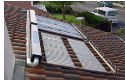
Figure 8.18 Les réflecteurs CPC qui équipent le deuxième capteur sont très sensibles au vent. De plus, leur rentabilité ne semble pas meilleure que celle des bardeaux d'aluminium bitumineux qui épousent la forme des tuiles sur l'ensemble de la surface du premier capteur.
