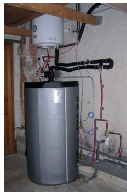
Figure 4.2 Ballon électrique de 150 l (en haut) couplé à un ballon de préchauffage solaire de 400 l (en bas).
