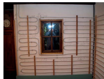
Figure 4.3 Mur chauffant en cours de réalisation.
