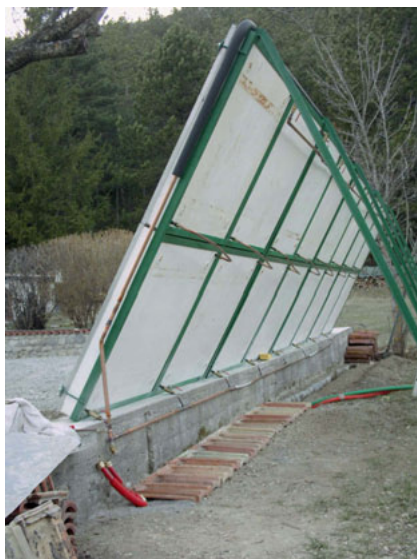
Figure 7.14 Mise en place des panneaux.
