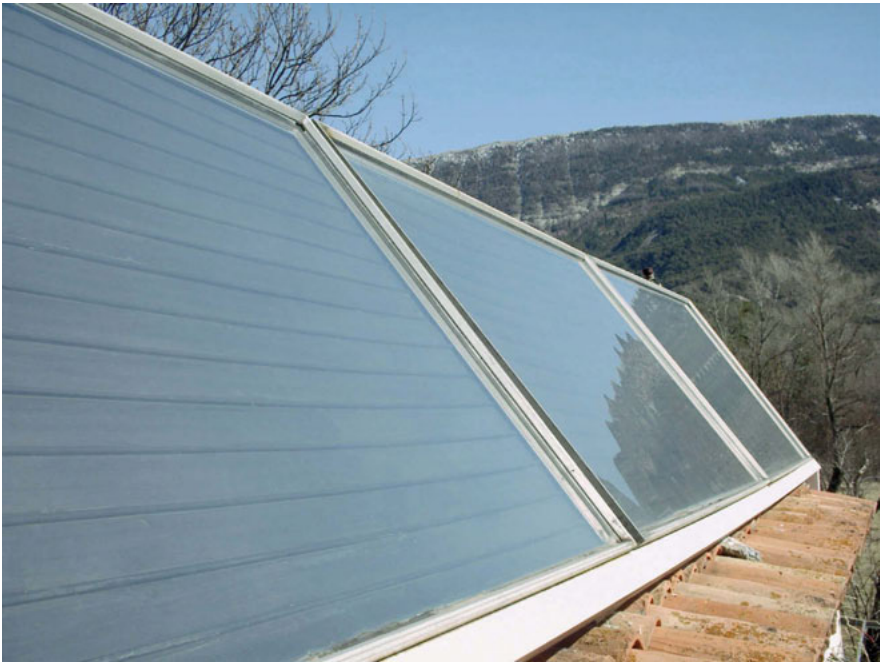
Figure 6.7 Les trois capteurs alignés et inclinés à 60°.
