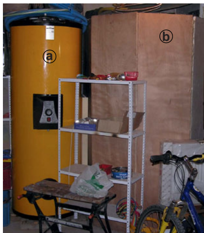
Figure 9.3 Les stocks de calories. (a) Eau chaude sanitaire 600 l 2 serpents. (b) Stock chauffage 1 500 l.
