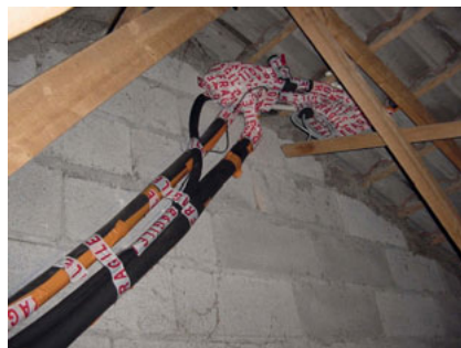
Figure 8.13 Les circuits solaire et d'apport d'eau de la soupape de décharge sont bien isolés dans les combles, pour éviter la perte d'énergie et le gel.
