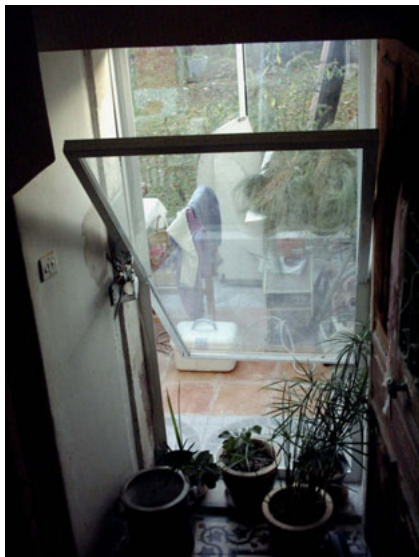
Figure 6.16 Porte à ouverture automatique permettant de profiter de l'apport passif de la véranda.
