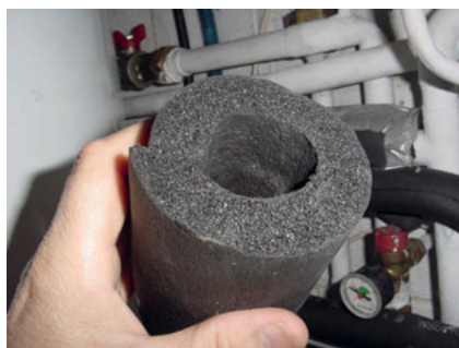
Figure 8.12 Utilisation d'une isolation de qualité.
