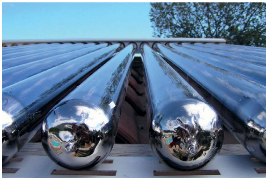
Figure 2.14 Les extrémités argentées des tubes du capteur, témoins du vide.
