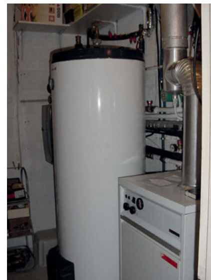
Figure 8.24 Le peu de place disponible ne permet pas un volume de stockage d'énergie suffisant. Il en résulte en été, de nombreuses activités de la soupape de décharge pour éviter les surchauffes !
