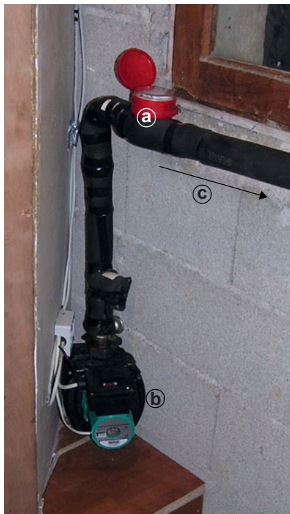
Figure 9.14 L'installation avec la pompe Wilo. (a) Compteur eau chaude (débitmètre). (b) Pompe Wilo Top S 7. (c) Vers panneaux.
