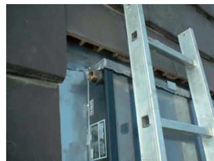
Figure 10.11 La bande de plomb est repliée au-dessus de chaque panneau.
