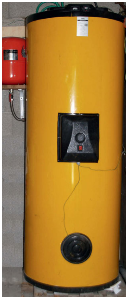
Figure 4.1 Ballon d'eau chaude sanitaire de 600 l.
