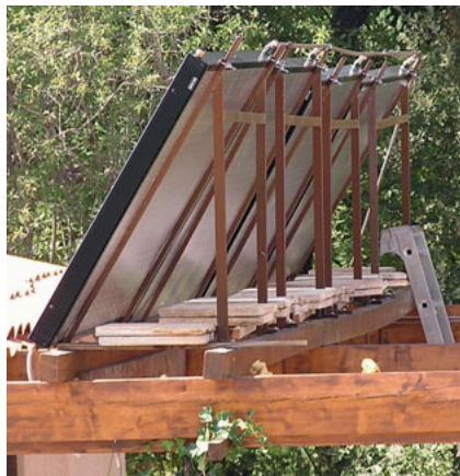
Figure 9.24 Positionnement des capteurs sur la pergola.
