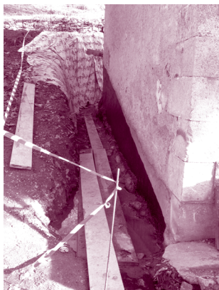
L'installation d'un drain périphérique nécessite de dégager en profondeur les pieds de fondation.
