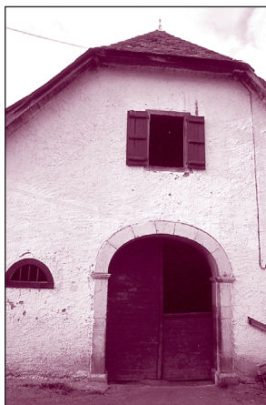
Dans la tradition (ici en Béarn), les maçonneries exposées étaient enduites à la chaux grasse.
