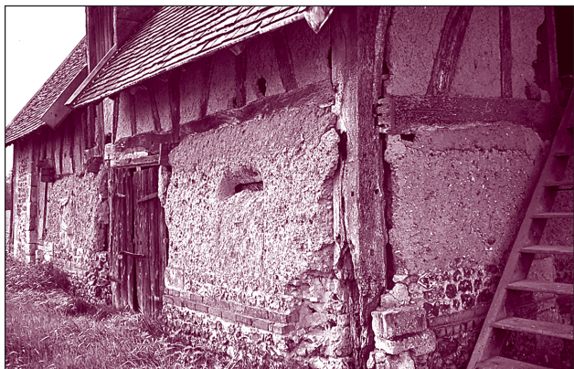
Le bois en œuvre craint avant toute chose l'humidité stagnante.
