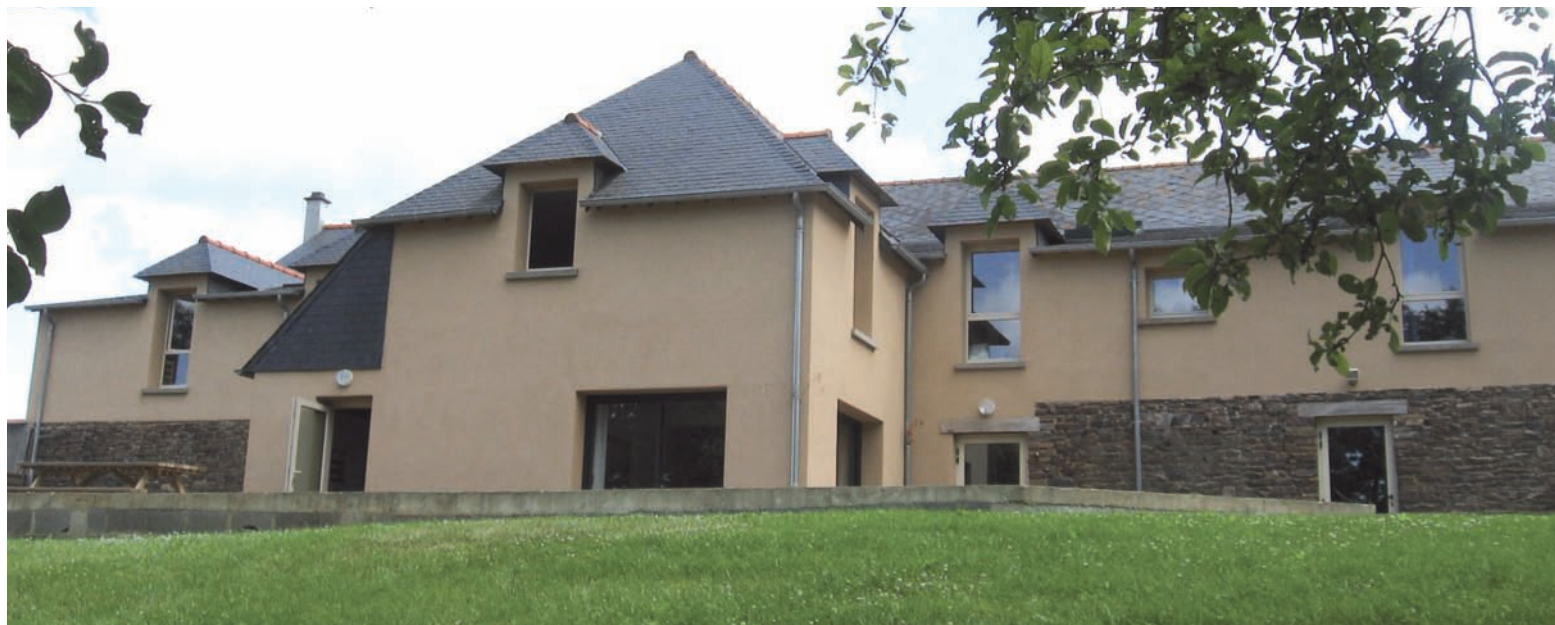
Gîte rural écologique en forêt de Brocéliande, réalisé en briques Monomur. À la différence de la maison à ossature bois avec remplissage en bottes de paille, il faut réaliser un très gros travail de maçonnerie pour arriver à ce résultat. Ici, l'autoconstructeur est issu du bâtiment...
