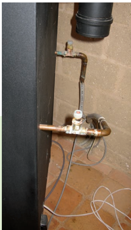
Les tuyaux qui permettent de chauffer le fluide caloporteur du ballon solaire lors de leur passage dans le foyer du poêle.
