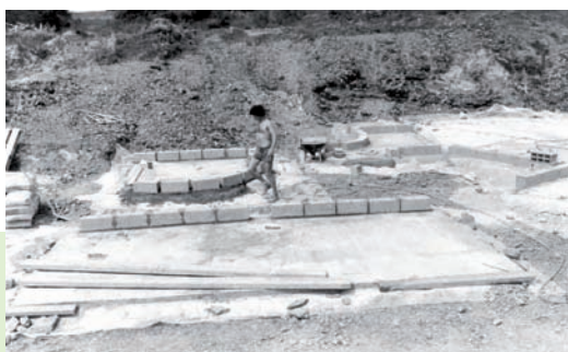
Le sol a été nivelé à l'explosif par un artificier. Ici, la dalle a été coulée sur une bâche en polyane. Les parpaings servent uniquement à délimiter les niveaux de la dalle. (Photo Patrick Marie.)
