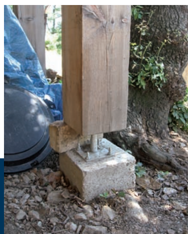
Une solution classique dans les maisons construites en poteaux-poutres, dont le bois ne doit jamais reposer dans le sol.
