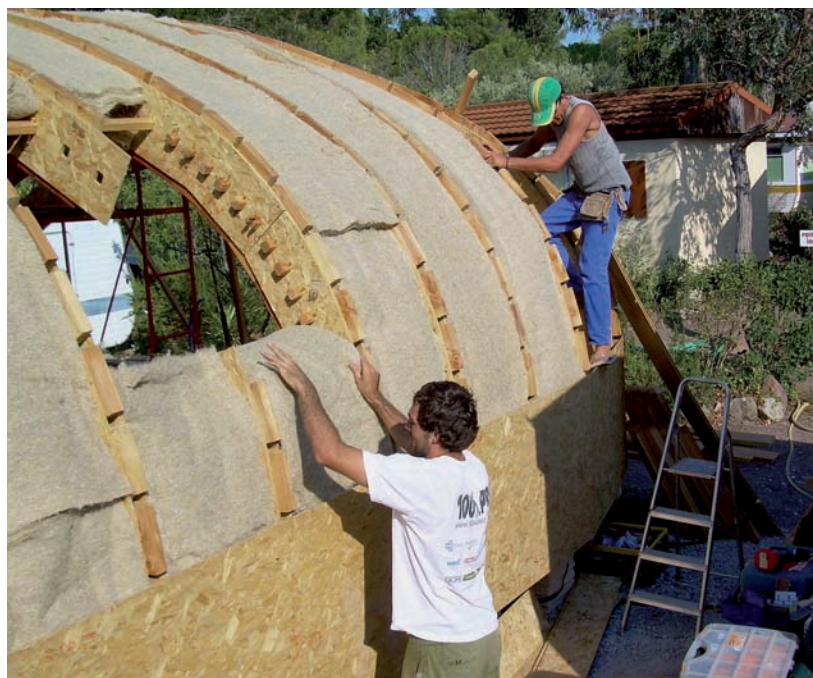
Mise en place de l'isolation d'une Écoquille. (Photo François Desombre/Martine Motte.)
