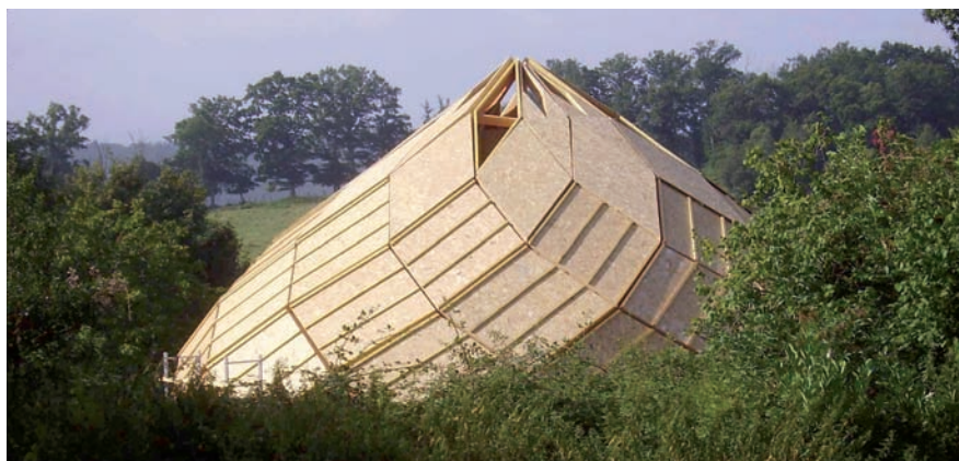
Exemple de zome. Il faut compter de 7 à 10 jours pour monter l'ossature, à partir d'éléments prémontés. (Photos Jean Soum.)
