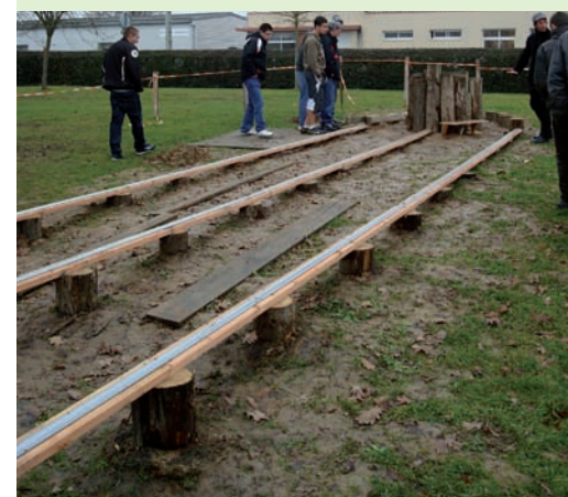
Après coupe à niveau des pieux de robinier, on a installé le rail. Au fond, la dizaine de pieux supportera le centre de la zone technique. (Photos Centre de formation des apprentis du bâtiment et des travaux publics du Mans.)
