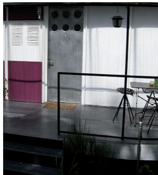
Détail d'une entrée : les fenêtres de la porte sont rondes car cette découpe est plus facilement réalisable par une machine ; ici, c'est donc l'industrie qui dicte sa loi pour les cotes, et non l'inverse, ce qui a valu à cet habitat le surnom de « machine à habiter ». D'un point de vue bioclimatique, il y a tout de même un problème : les habitats sont très peu isolés, pleins de ponts thermiques. Les gens se plaignent d'avoir froid l'hiver.
