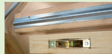
Détail du rail et des roulettes pour le déplacement de la partie mobile de l'habitat.
