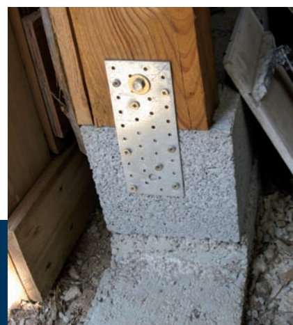
Une autre manière d'assurer sans trop de dépenses la fixation des poteaux verticaux (bergerie). Il faut cependant que les vis fichées à l'horizontale dans les parpaings soient suffisamment longues et noyées dans le mortier.
