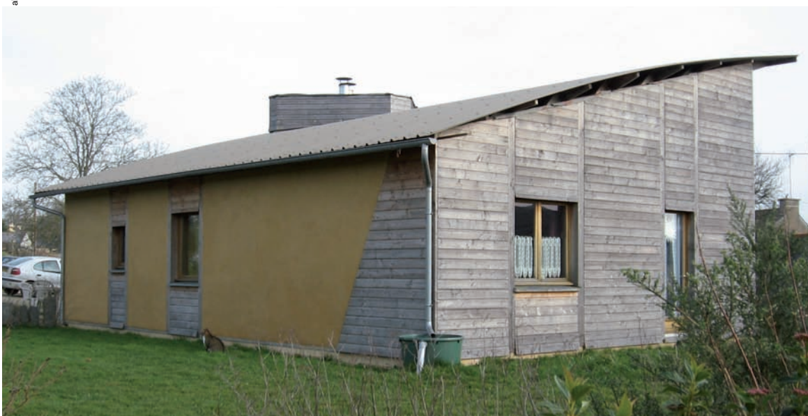
Une toiture en bac acier a été posée sur les pannes, elles-mêmes vissées sur les poutres en I et reposant sur les plaques OSB qui ont servi à coffrer la paille qui isole le toit (avec interposition d'un film pare-pluie). Afin d'éviter les condensations sous les plaques d'acier, celles-ci sont « floquées ». La pente douce du toit a permis l'utilisation de plaques bac-acier courantes, c'est-à-dire planes et donc moins chères que s'il avait fallu les commander avec une courbure ad hoc.
