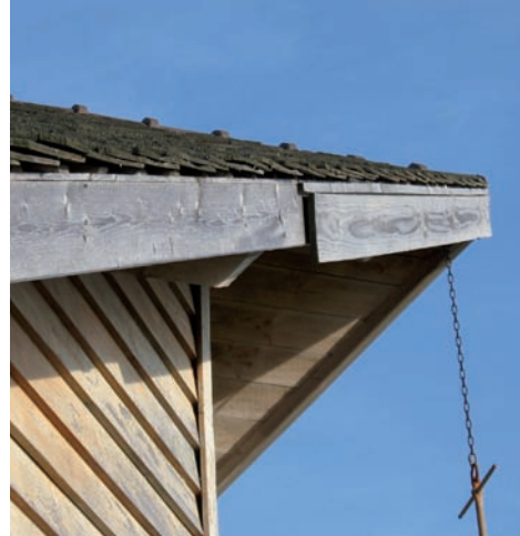
Détail de l'étrave et de sa protection en lames de pin Douglas...
