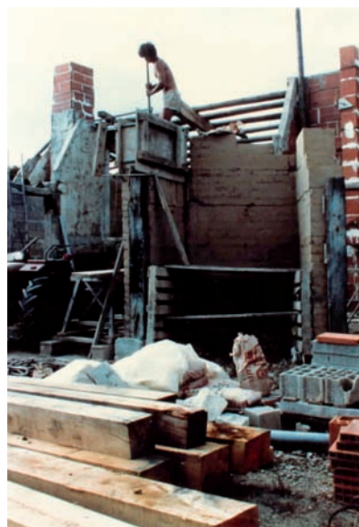
On reconnaît les ingrédients : murs de terre, traverse de chemin de fer, début de la charpente en poteaux PTT, briques pour la future cloison intérieure (qui est porteuse). Ici, le coffrage atteint sa hauteur maximale. (Photo Patrick Marie.)
