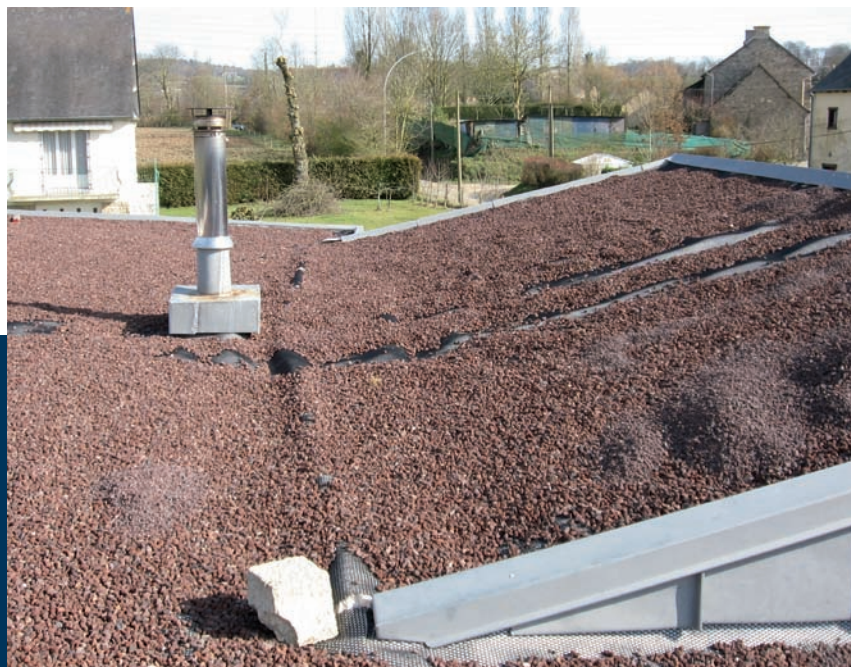
La toiture végétale en cours de réalisation. C'est sur de la pouzzolane (une pierre poreuse en vente dans toutes les grandes surfaces de bricolage) que sera placée la terre du toit : elle rajoutera à la masse thermique de l'habitat, lui apportant notamment beaucoup de fraîcheur en été.
