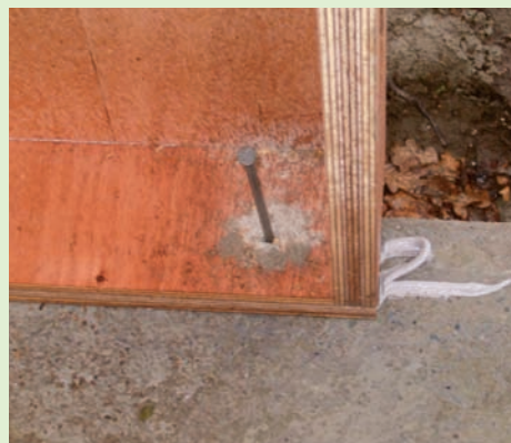
Raccord du module à la dalle avec une cheville à frapper avec perçage préalable. Cette cheville maintient les modules en place le temps de la polymérisation (donc de la prise) de la colle. Dessous, pose de 2 cordons de mastic polyuréthane PU 40, pour l'étanchéité et le collage de la structure sur la dalle. (Photo Jacques Duthilleul.)
