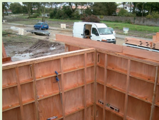
Liaison des modules entre eux : on a placé en haut une lisse plate de stabilité « standard », qui chaîne horizontalement la structure... Elle recevra ultérieurement les aiguilles de toiture. À droite de la photo, un autre type de lisse, en « L », sert à la fois de chaînage horizontal et de point d'appui pour les panneaux Béopan. (Photo Jacques Duthilleul.)
