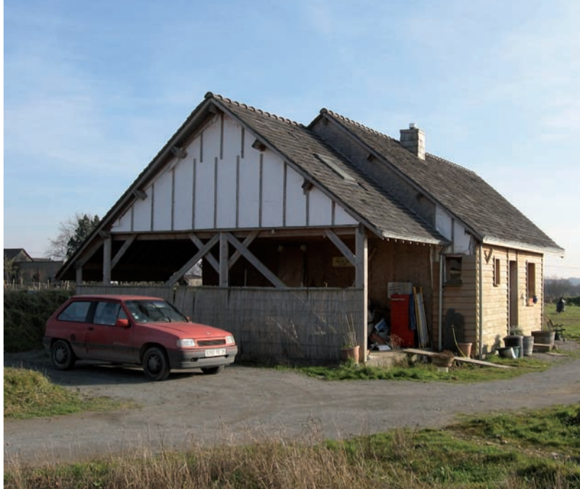
La maison vue de l'appentis : les pièces verticales sont posées, attendant de recevoir le bardage en pin Douglas.
