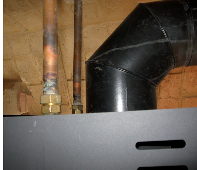
Ce poêle (Néria, 7 kW, environ 700 €) est équipé d'un bouilleur, lequel va être utilisé en circuit avec...
