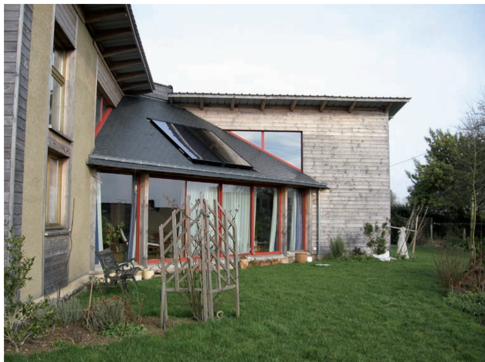
Le panneau, de 5 m 2 , du chauffe-eau solaire.
