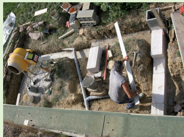
Mise en place d'une isolation périphérique enterrée, ponctuée par les plots qui supporteront les poteaux verticaux d'une ossature bois.
