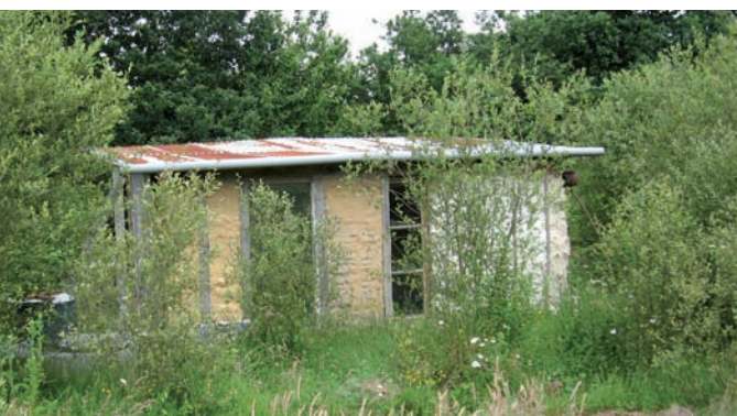
Autre cabane : l'occupant se plaint du toit de tôle. Énorme pont thermique, il condense en outre l'humidité de l'air, qui retombe en gouttes sur le sol en terre battue...
