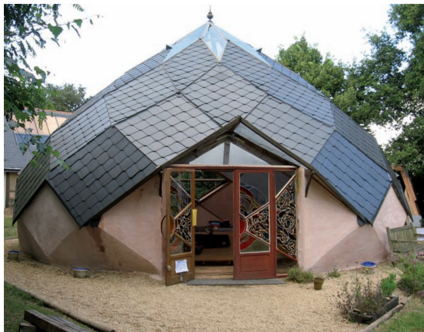
Zome des Baronnet. La forme globale est ronde... Pour y arriver, on a associé de petites surfaces planes, dans un jeu apparement savant d'angles combinés.
