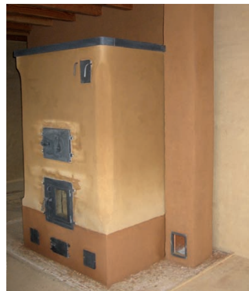
Au cœur de l'habitat, un poêle de masse fait en briques de terre crue qu'ont pressées eux-mêmes Elisabeth et Jean-Michel grâce à une presse fournie par l'association Empreinte (voir page 119). La terre des briques est une terre pure, prise à fleur de sol et tamisée grossièrement : faites en novembre, utilisées en février, les briques ont été complètement sèches en mars-avril. Un ouvrier spécialisé a fabriqué lui-même le poêle, recevant une rémunération de 5 500 € en chèques emploi-service (dans le meilleur des cas, un poêle de masse traditionnel coûte une dizaine de milliers d'euros).
