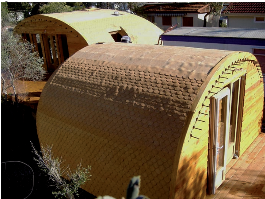
Couverture en tuiles de liège de l'Écoquille. (Photo François Desombre/Martine Motte.)
