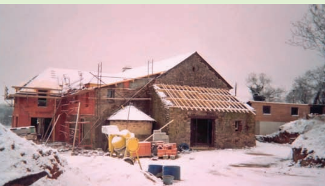
On va donc associer les murs massifs anciens conservés à la brique Monomur. Mais se pose un problème bioclimatique : cette partie est au nord... On va donc l'étendre vers le nord, de manière à ménager des ouvertures à l'est et à l'ouest. (Photo Béatrice et Gérard Jarno.)
