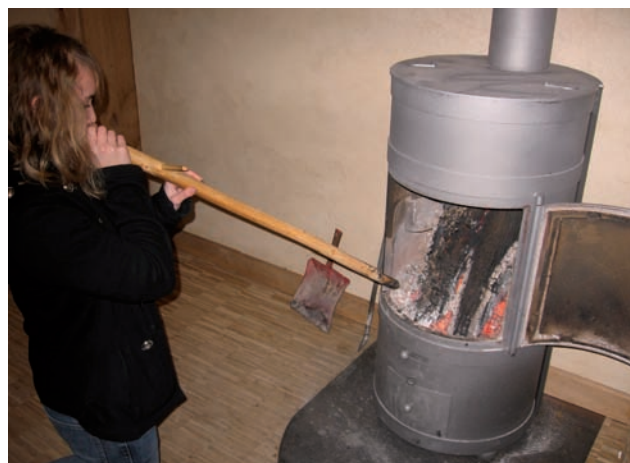
C'est avec ce bâton creux (le « bouffadou », qui viendrait d'Auvergne), dans lequel on souffle, qu'on allume ce poêle turbo : le bioclimatisme, c'est aussi l'art d'associer l'ancien et le moderne.
