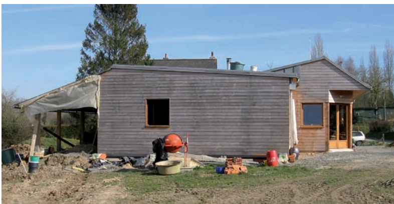
Façade ouest : le bardage en pin Douglas représente une protection supplémentaire face aux vents dominants, qui apportent de la pluie dans cette région océanique.
