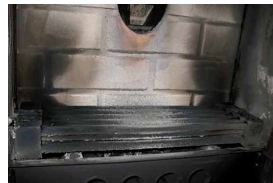
Les tuyaux qui permettent de chauffer le fluide caloporteur du ballon solaire lors de leur passage dans le foyer du poêle.
