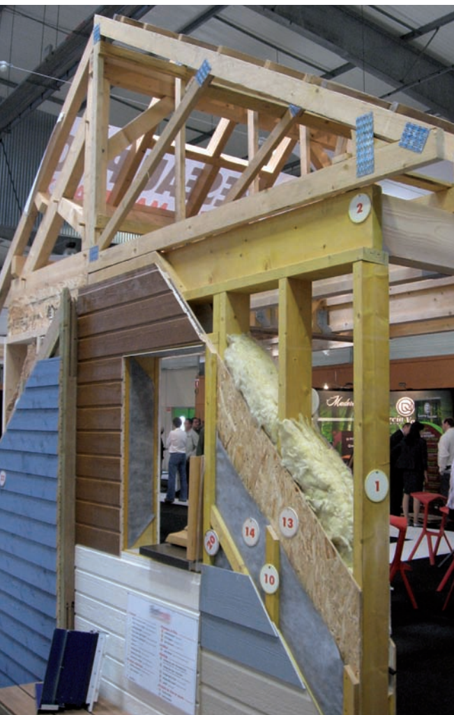
Cette maison, montée pour un salon ouvert à tous, est vendue en pièces détachées aux particuliers. La complexité des découpes montre cependant que le système a été conçu pour un montage par des professionnels.
