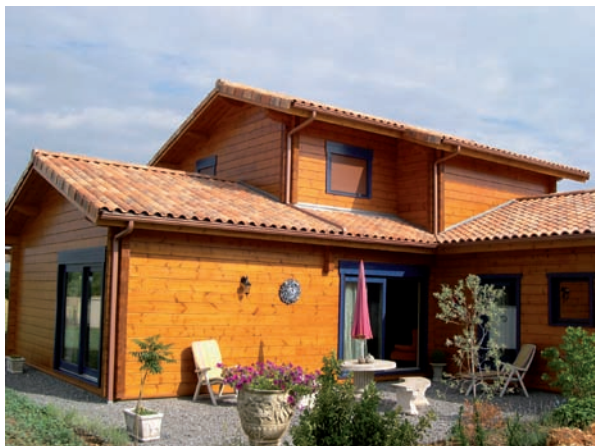
Le madrier empilé, dès lors que la dalle est d'une planitude parfaite, se prête vraiment bien au jeu de l'autoconstruction. (Maison et photo Guillaumie.)
