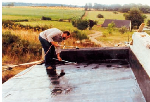
L'étanchéité d'une maison enterrée est fondamentale : à ce jour, les rouleaux bitumineux soudés au chalumeau restent l'un des meilleurs produits. (Photo Patrick Marie.)
