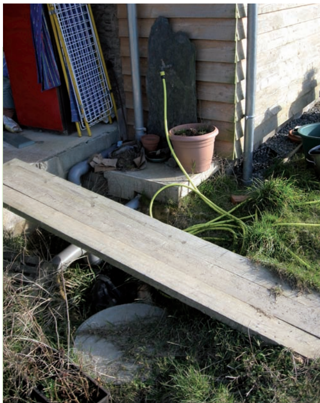
La réserve d'eau de pluie : selon Chantal, elle a été enterrée un peu trop profondément, ce qui pose un problème en cas de trop-plein.
