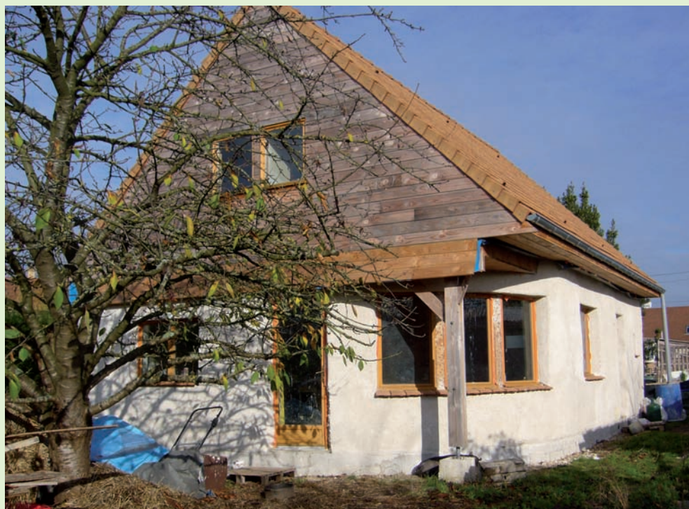
Sur ce chantier, les Compailleurs sont intervenus en amont, à la définition du projet, puis en aval, suivant l'autoconstructeur (devenu depuis constructeur !), de la charpente au remplissage en bottes de paille et à leur enduit. (Photo Christine et Jésus Ramos.)
