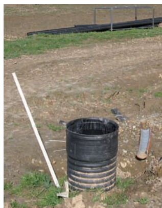
La prise d'air du puits canadien, qui débouche avec son air à 12 °C directement sous le poêle de la grande pièce, qu'il alimente en air frais (sinon ce dernier prendrait l'air dans la pièce, interdisant de la chauffer efficacement).
