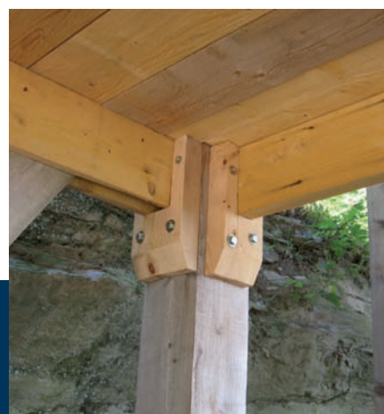
La fixation des poutres sur les poteaux verticaux : plus complexe que par sabots métalliques, mais originale, solide et belle, à notre sens.
