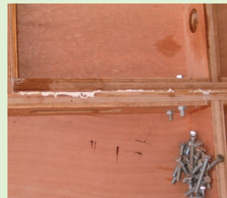
Liaison entre 2 modules 3D : ils sont boulonnés et collés par la même colle que celle utilisée pour les accrocher à la dalle. (Photo Jacques Duthilleul.)
