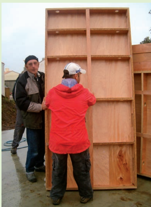
On voit ici parfaitement les modules, dont l'épaisseur est de 12,6 cm. Les trous servent au passage des fluides. Les trous verticaux sont oblongs de manière à créer les pentes nécessaires à l'écoulement des eaux usées. Ces percements aident au placement des modules. (Photo Jacques Duthilleul.)
