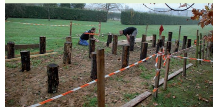
Mise en place des pieux « battus » de robinier (un faux acacia) qui supporteront l'ensemble de la structure : autrefois, on utilisait ce type de pieu pour les fondations, « battus » signifiant qu'on a frappé dessus pour les enfoncer.
