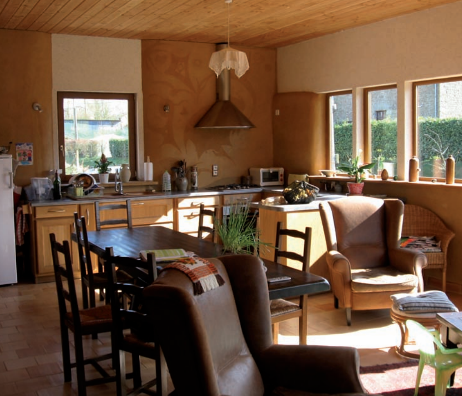
Le séjour : murs en bottes de paille (35 cm x 45 cm x 1 m) recouverts d'un enduit terre, support d'un décor dans la partie cuisine et sol en tommettes...
