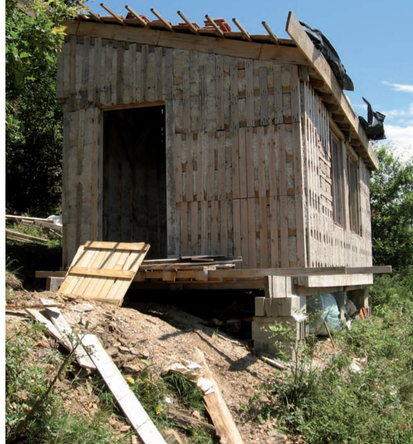
Une maisonnette en autoconstruction : entièrement réalisées en palettes de bois (voir aussi page 60) remplies d'un mélange chaux-copeaux (pour l'isolation), elle recevra un bardage bois extérieur-intérieur. Tous les matériaux sont récupérés ou pris sur place.
