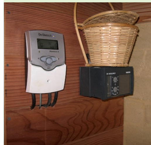
L'électronique de gestion du ballon d'eau chaude et du capteur solaire.
