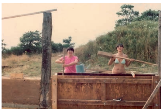
On tasse (familialement) la terre entre les deux panneaux du coffrage en bois, qu'on montera au fur et à mesure. (Photo Patrick Marie.)
