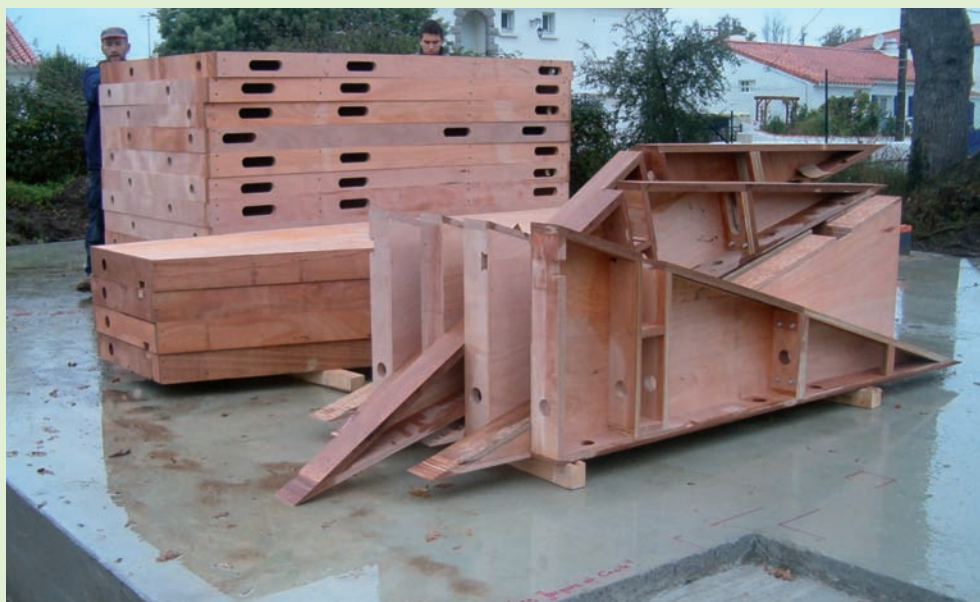
Les modules sont disposés sur la dalle en béton réalisée au préalable : si vous faites couler cette dalle par un maçon, elle disposera de la garantie décennale à part du reste de la maison. Attention : la structure 3D étant indéformable, la société demande au maçon des normes de planimétrie nettement supérieures à celle des DTU (type béton autonivellant). (Photo Jacques Duthilleul.)
