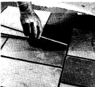
Obtenez des joints uniformes en plaçant un tasseau de 3/8" entre les carreaux.
