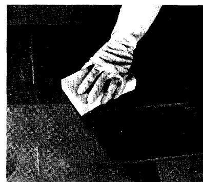
Essuyez l'excédent de coulis avec une éponge humide. Polissez au linge sec.
