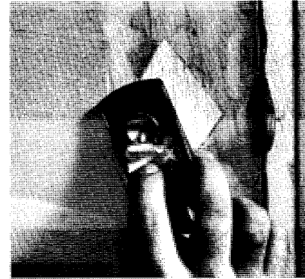
3. Remplissez les cavités de pâte de bois. Après le séchage, rabotez et poncez à fond jusqu'à l'obtention d'une surface absolument unie et douce.
