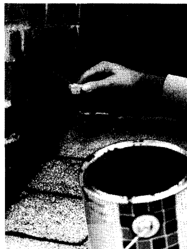
Le solin de la cheminée peut laisser l'eau s'infiltre par les joints. Couvrez généreusement de ciment noir à toiture.
