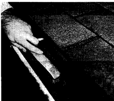
Frottez la partie endommagée avec du papier de verre ou une brosse d'acier et nettoyez la section à réparer.
