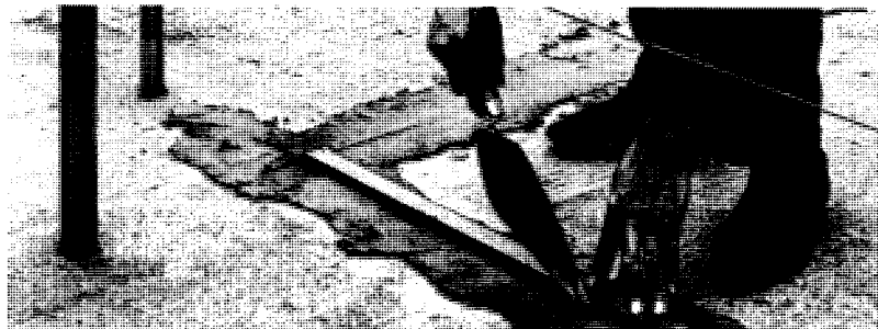
3. Répétez l'opération en faisant une deuxième marque à la truelle à 2' de la première. Reliez les marques en utilisant une règle de maçon pour tracer une ligne (A). Tracez ensuite la ligne (B) perpendiculairement à la ligne (A). Répétez l'opération à tous les angles ou têtes de mur. Prenez votre temps pour cette opération, car c'est d'elle que dépend l'alignement correct du travail.
