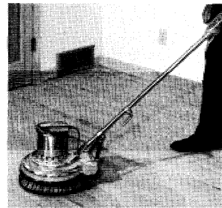
Laissez sécher pendant trois jours, puis appliquez de la cire en pâte et astiquez. Étendez une seconde couche et polissez.
