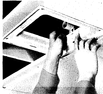
Placez la boîte de jonction sur le châssis-adaptateur et raccordez les fils à la ligne électrique (p. 266). N'oubliez pas de laisser un espace pour l'interrupteur.
