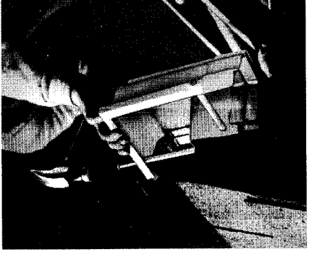
Posez une pâte à calfeutrage sur les dispositifs d'assemblage, pour assurer l'étanchéité.
