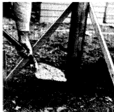
Démêlez du béton (p. 469) et versez-le dans le trou autour du poteau.
