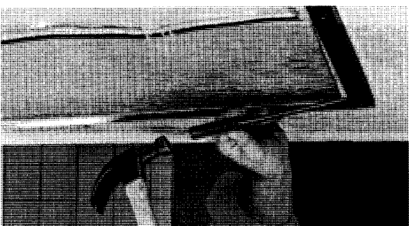
Retirez le sommet et la base du cadre et dévitez celui-ci. Allez-y avec délicatesse pour éviter les ébarbures.
