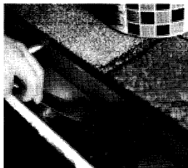
Essuyez les grains abrasifs avec un linge trempé dans du diluant à peinture; posez une couche de ciment asphalté.
