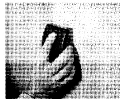
A l'aide de papier abrasif à grain moyen, monté sur un bloc, poncez la surface pour la rendre unie et lisse.
