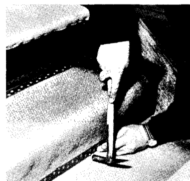
Au lieu de supports en pièces, utilisez un support continu. Par-dessus, clouez les bandes à griffes à la contremarche.
