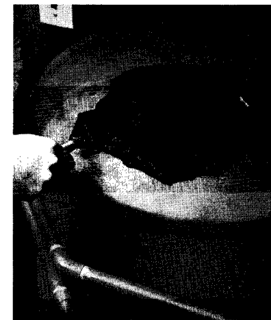
Une épaisse couche de mastic peut isoler un réservoir et arrêter la condensation; appliquez 1/4" à la fois.
