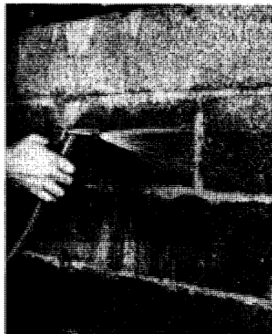
Vaporisez de l'eau sur les murs du sous-sol avant de poser un matériau imperméable à base de ciment.
