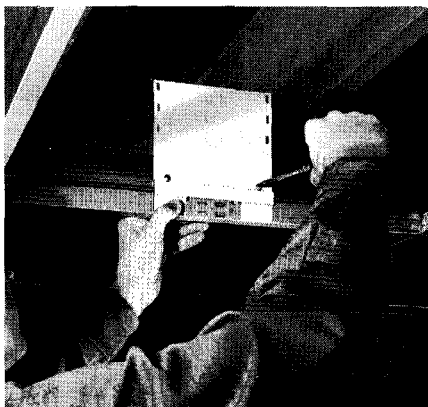
Pour installer une lampe fluorescente dans un plafond suspendu, attachez les supports de montage aux brides des rails et assujettissez-les avec des vis.
