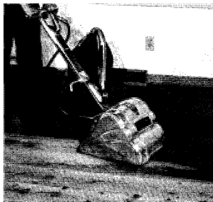
Commencez le ponçage avec du papier à gros grain. Suivez le fil du bois. Le même papier doit servir au premier ponçage entier.
