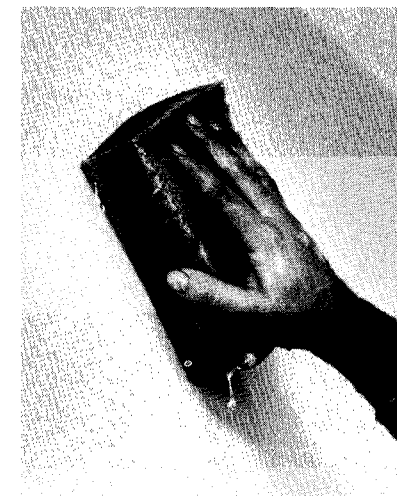
Lavez à fond à l'eau additionnée de détergent. Laissez sécher à fond avant de peindre.
