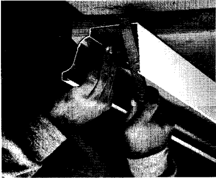
Limez les barbes pour faciliter l'installation des dispositifs d'assemblage.
