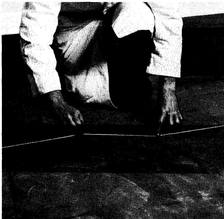
Le tracé à la craie: Sur les grandes surfaces, faites claquer une moitié de la corde à la fois.
