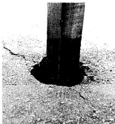
Pilonnez à l'aide d'un 4" x 4". Voyez à ce que l'asphalte adhère solidement aux parois de la cavité.
