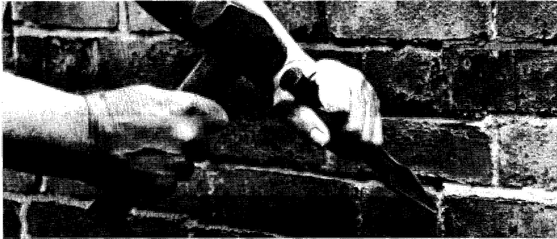
Les joints détériorés laissent pénétrer la pluie. Utilisez un bédane de \frac{3}{8} " et un marteau de 2 \frac{1}{2} lb pour enlever le vieux mortier sur 1 verge carrée de mur. Nettoyez les joints verticaux puis les horizontaux à une profondeur de \frac{1}{2} ".
