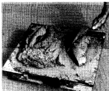
Pour ramasser le mortier , coupez-en une tranche avec la truelle; glissez-la vers vous. Arrondissez le bord coupé.
