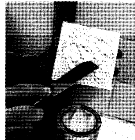
4. Appliquez de la colle avec un couteau à mastiquer sur le dos de la nouvelle tuile, jusqu'à 1/2" du bord.
