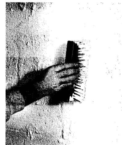
Appliquez une deuxième couche de mélange dans les 24 heures. Humectez le mur à nouveau avant la seconde couche.
