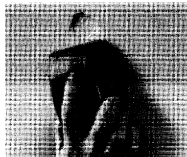
Passez au papier abrasif la surface à réparer pour donner prise à la pâte.
