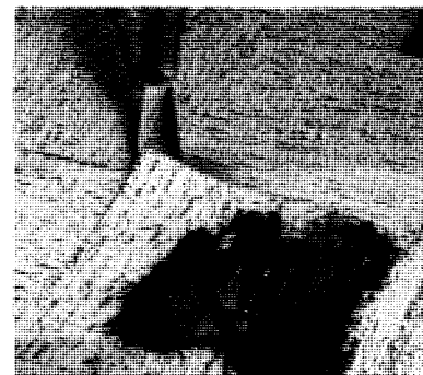
A l'aide d'un couteau à mastiquer, soulevez délicatement le carreau, sans endommager les carreaux voisins.
