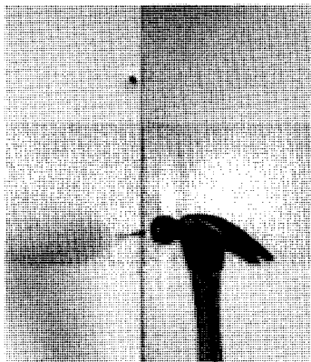
Plantez les clous à environ \frac{3}{8} " ou \frac{1}{2} " des bords des panneaux. Enfoncez-les perpendiculairement pour que leur tête soit au niveau de la surface.
