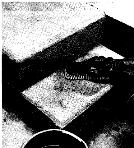
Enlevez la graisse et l'huile en lavant la surface avec du nettoyeur TSP et de l'eau chaude. Rincez à l'eau claire.
