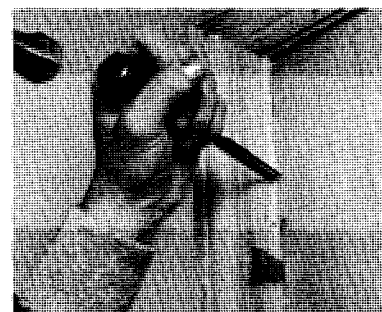
Marquez l'endroit des charnières sur la porte et le jambage simultanément.
