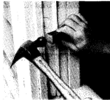
Si le châssis reste coincé, martelez les arêtes des rainures en utilisant un bloc pour repousser le bâti.
