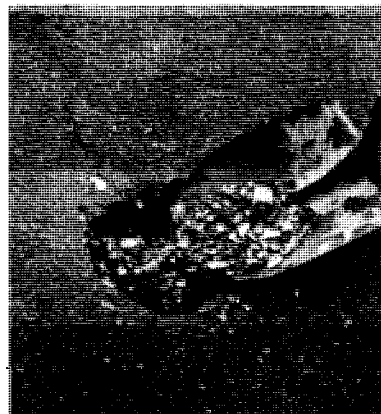
Si le trou est profond, remplissez-le de gros gravier jusqu'à 3" ou 4" du bord. Pilonnez solidement.
