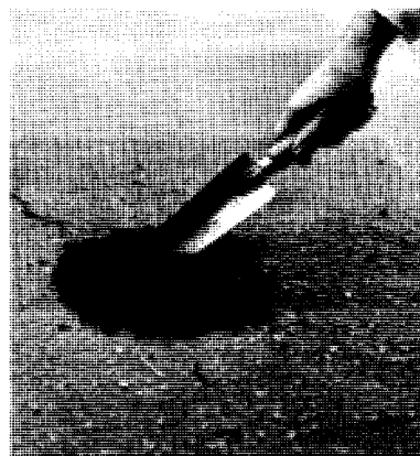
Versez assez d'asphalte dans le trou pour former une butte excédant de 1/2" la surface de l'allée.
