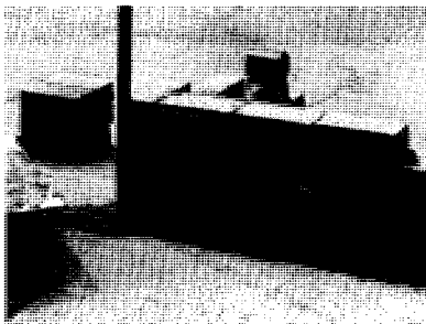
10. Le vaporifuge une fois posé, montez plusieurs rangs au coin; chacun d'eux est plus court que le précédent. Servez-vous d'un poteau gradué pour vous assurer que les rangs montent régulièrement.
