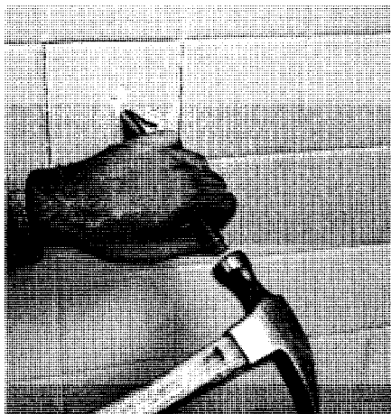
1. Retirez le carreau défectueux en enlevant le vieux coulis dans les joints. Ensuite, brisez-le avec un ciseau et un marteau.
