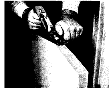
Rabotez selon les repères sur la porte pour enlever seulement le nécessaire aux endroits surélevés.
