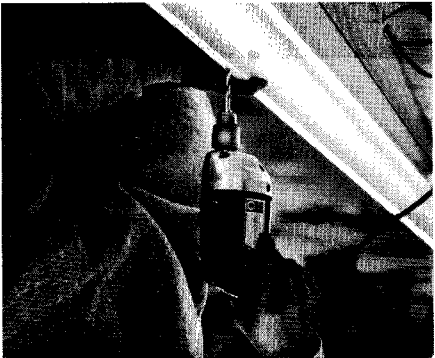
Si vous utilisez des clous, percez des trous dans la gouttière, près des rebords.
