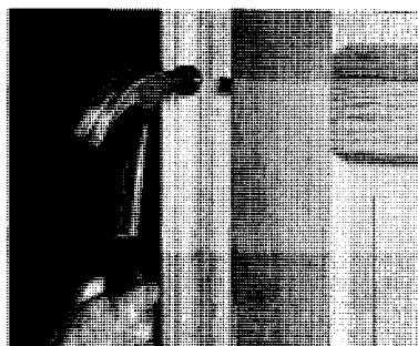
Enfoncez des coins sur les 4 côtés de la nouvelle porte pour la tenir en place.
