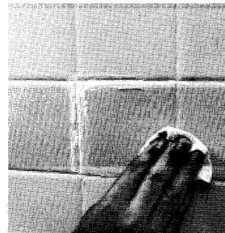
8. Avec un linge humide ou une éponge, enlevez le surplus. Un diluant à peinture enlèvera la colle restée sur les carreaux.
