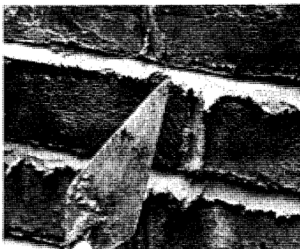
Les joints verticaux doivent s'harmoniser avec les joints horizontaux.
