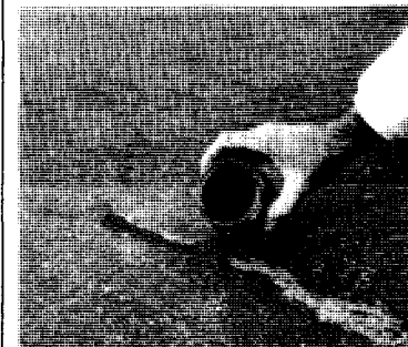
Réparez les fissures et lézardes avec un scelleur spécial. Remplissez-les en partie de sable, puis versez le scelleur; de préférence, durant une journée chaude.
