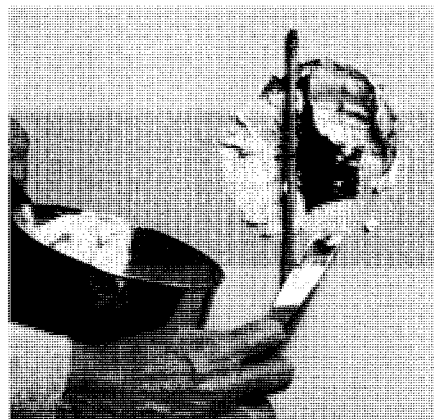
Faites pénétrer une première couche de plâtre dans le treillis, tel qu'illustré.
