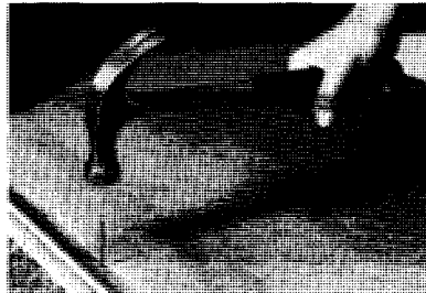
1. Si le plancher est très gauchi ou inégal, recouvrez-le d'un panneau dur. S'il s'agit de carreaux descellés, enlevez-les et obturez avec du rempli.
