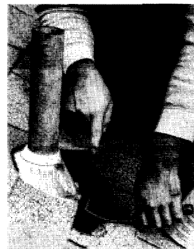
Posez une couche épaisse de ciment asphalté à toiture autour du solin et en amont du tuyau d'évent.
