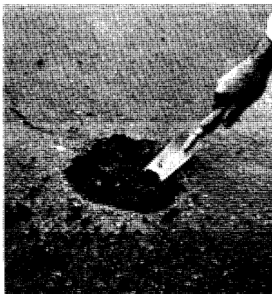
Enlevez les morceaux brisés et effrités; retirez tous les débris. Les parois de la cavité doivent être solides.
