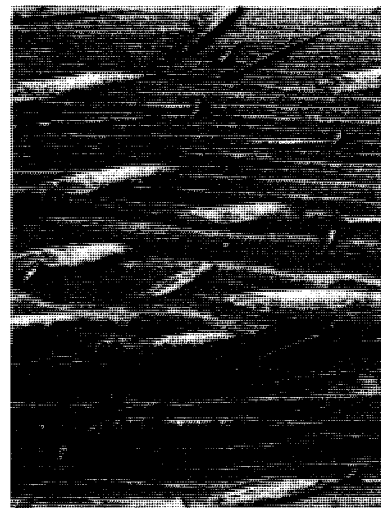
Pin "vieilli" avec une chaîne à chien et un marteau. Blessures supplémentaires faites au ciseau et à la gouge. Teinture, scelleur. Ce fini est excellent pour les poutres.
