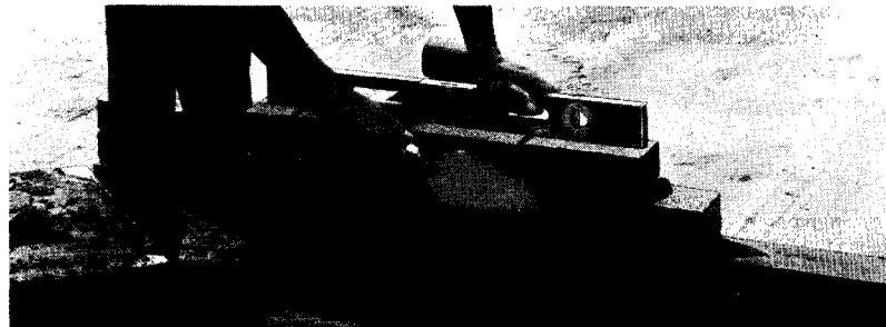
11. Utilisez constamment le niveau pour vérifier la régularité. Vérifiez l'ouvrage verticalement, horizontalement et en diagonale, en tenant le niveau en biais contre le mur, à partir de la brique d'angle et en tapotant le bord des briques sorties de l'alignement pour les remettre en place. Elevez l'autre coin jusqu'à la même hauteur. Tendez le cordeau entre les coins et complétez les rangs jusqu'à la hauteur désirée.
