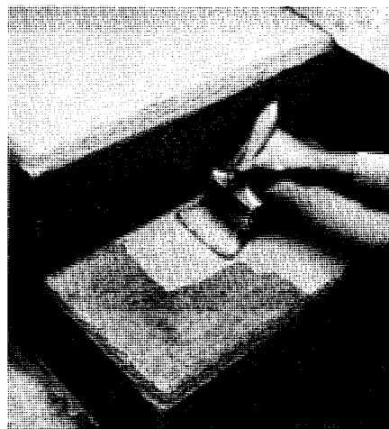
Appliquez la peinture libéralement et faites-la pénétrer dans les lézardes; ajoutez une 2 e couche après un séchage de 24 heures.
