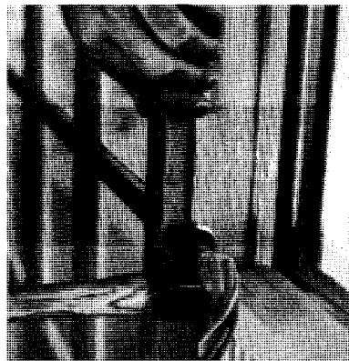
Démontez le châssis , si le dispositif à ressort est cassé. Aplatissez la glissière à petits coups de marteau.
