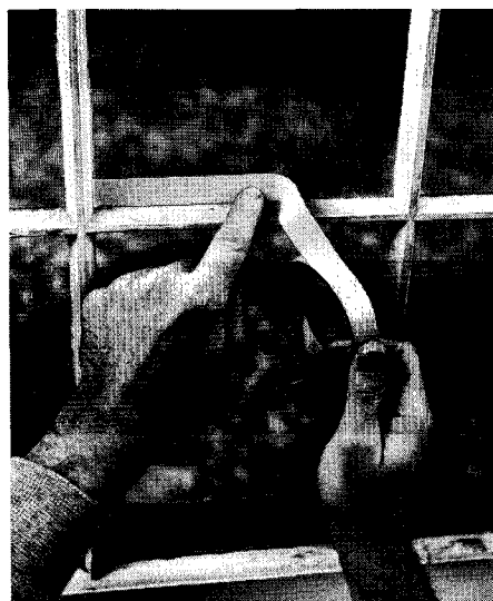
Servez-vous de ruban gommé ou d'une tôle pour protéger les vitres.
