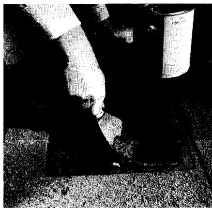
Appliquez du ciment à toiture sur la surface ainsi dégagée et sur les quatre côtés de la sous-face. Levez délicatement.
