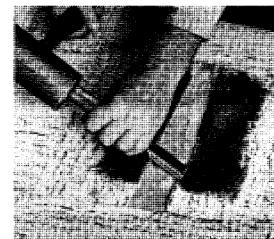
Il est aussi possible d'arracher le carreau avec un ciseau. Partez du centre et progressez vers les bords.
