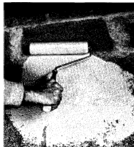
Les rouleaux à longs poils sont requis pour peindre les surfaces rudes. On les utilise comme les rouleaux ordinaires.
