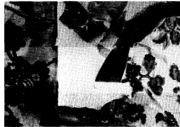
Quand le papier a trempé assez longtemps pour se ramollir, enlevez-le avec un couteau à mastiquer. Attention au plâtre.
