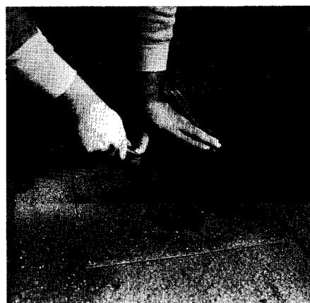
Pour réparer une grande surface, coupez la section endommagée et retirez-la. Coupez, de préférence, en carré ou en rectangle.
