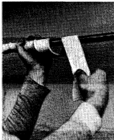
Enroulez un isolant en fibre de verre autour d'un tuyau d'eau froide pour l'empêcher de goutter par temps humide.
