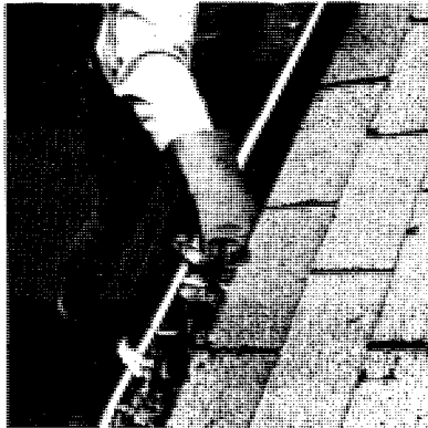
On enlève les débris d'une gouttière avec les mains (gantées). Lavez au boyau les débris qui restent.
