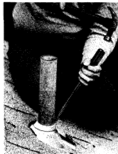
Les tuyaux d'évent laissent l'eau s'infiltre autour du calfeutrage. Tassez le plomb sur le tuyau avec un tournevis.
