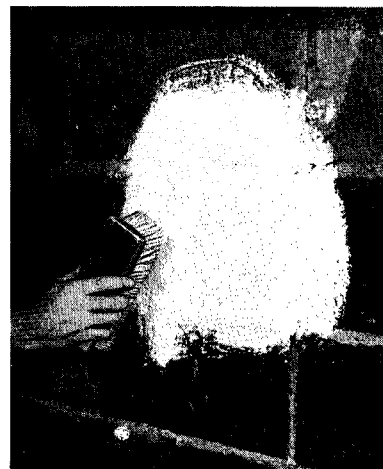
Appliquez le mélange avec une brosse raide en suivant le mode d'emploi. Faites-le pénétrer dans les fissures.
