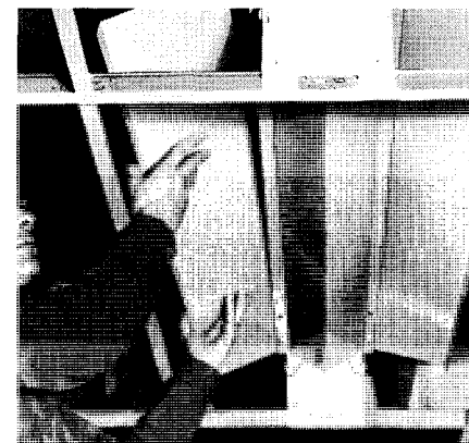
Posez les panneaux réflecteurs. Branchez l'appareil au courant qui convient. Prévoyez la pose d'un interrupteur et mettez en place les lampes fluorescentes.
