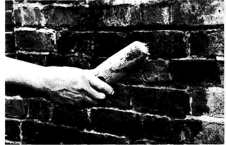
Brossez les joints et mouillez-les avec un fin jet d'eau pour éviter que le vieux mortier n'absorbe trop vite l'eau du nouveau mortier.
