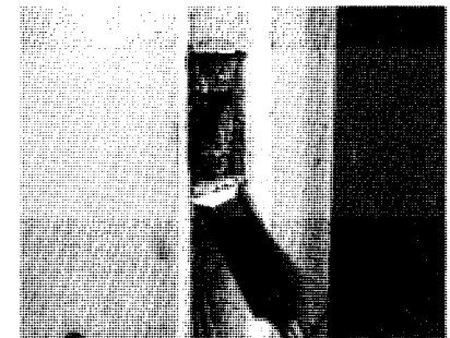
Si la gâche et le verrou sont trop éloignés l'un de l'autre ou si la porte branle, remplacez la gâche dans une nouvelle mortaise.
