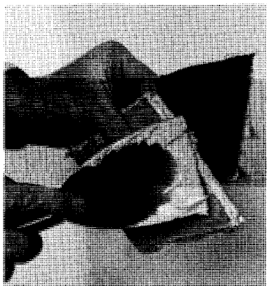
Elargissez l'ouverture autour du trou. Posez une pièce; recouvrez les rives de pâte.
