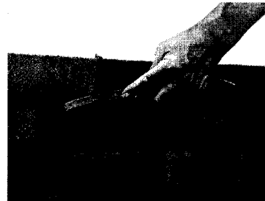
14. Pointez ensuite les joints horizontaux de la même manière, pour former un joint creux. Enlevez l'excès de mortier. Pour d'autres façons de pointer les joints, voyez la page suivante.
