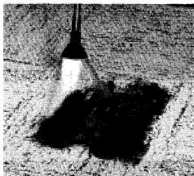
Chauffez le carreau endommagé avec un fer à repasser ou une lampe à souder, juste assez pour ramollir l'adhésif.
