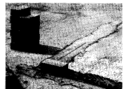
4. Étendez un lit de mortier d'environ \frac{1}{2} " dans un coin, en veillant à ne pas couvrir les lignes. Posez la brique contre la ligne. Vérifiez son niveau horizontal et vertical ainsi que sa hauteur.
