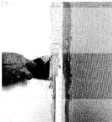
Pliez le ruban perforé sur la ligne médiane et posez-le en l'enrobant de pâte.
