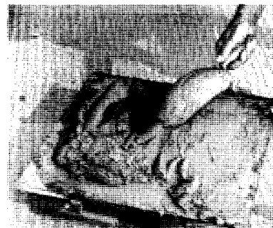
Soulevez le mortier en glissant la truelle par-dessous et par l'arrière pour la charger d'un "boudin" de mortier.
