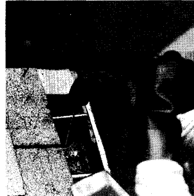
Des obstructions se produisent souvent dans le coude entre la gouttière et la descente. Dégagez avec un fil de fer.
