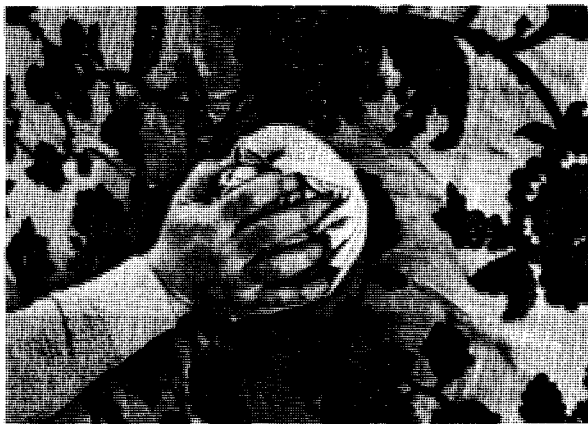
Enlevez le vieux papier avec une machine à décoller ou imbibez-le d'un mélange d'eau et d'un produit qui facilite le décollage.
