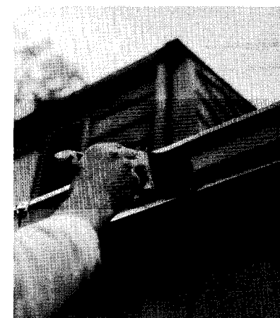
Finissez l'intérieur des gouttières à l'asphalte; l'extérieur à la peinture.
