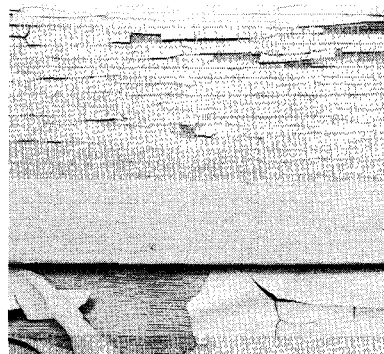
Boursoufflures et écaillage
