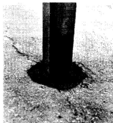
Pilonnez la butte jusqu'au niveau environnant. Faites rouler la voiture sur la réparation pour la tasser.
