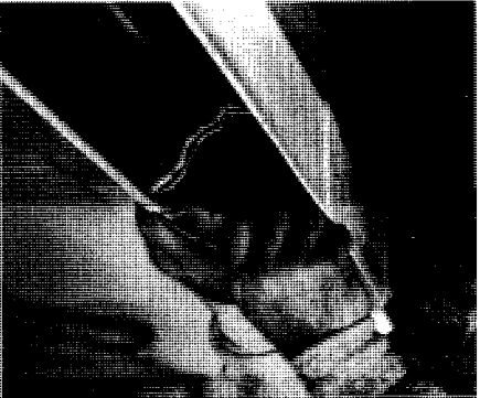
Si vous utilisez des clous, percez des trous dans la gouttière, près des rebords.
