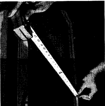
Mesurez l'ouverture; allouez 1/2" par pied pour l'expansion thermique.
