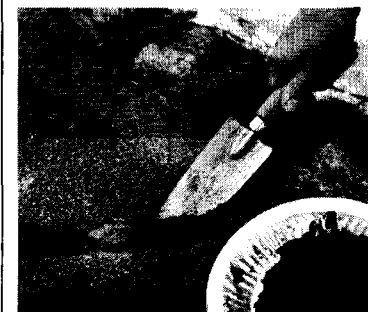
Remplissez la cavité d'asphalte jusqu'à 1" du bord. Hachez avec une truelle pour éviter les poches d'air.
