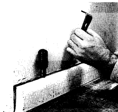
Si les plinthes doivent être enlevées, éloignez-les du mur avant de peindre.
