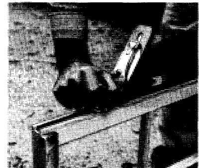
Rabotez légèrement les rives latérales du châssis, vérifiez l'emboîtement, puis remontez tous les éléments.
