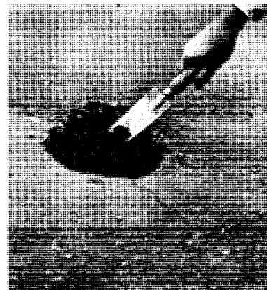
Remplissez la cavité d'asphalte jusqu'à 1" du bord. Hachez avec une truelle pour éviter les poches d'air.
