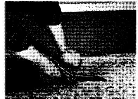
4. A l'aide de gros ciseaux, taillez le vinyle sur les tracés. Roulez le matériau à l'envers et transportez-le dans la pièce où il doit être posé.
