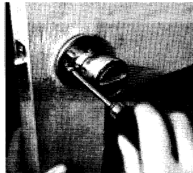
7. Posez le bouton intérieur et la rosette; centrez les vis et les tiges. Placez la rosette à ras de la porte.
