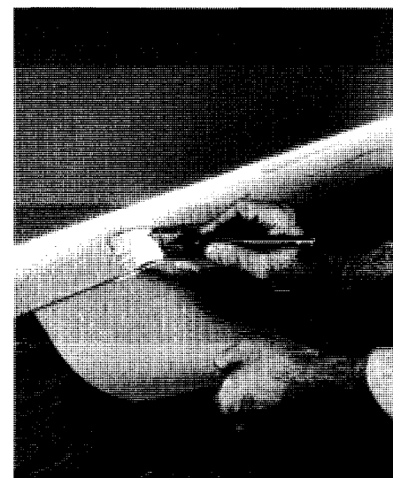
Couvrez le haut des plinthes, puis leur base. Protégez le plancher avec du carton.
