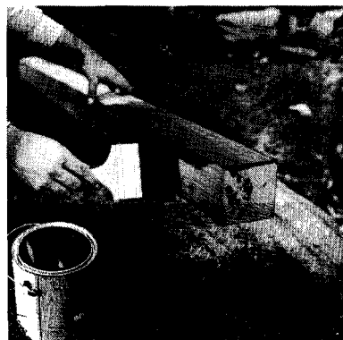
Enduisez les poteaux d'un préservatif à bois contre insectes et pourriture.
