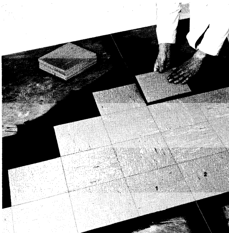
1. Posez les carreaux en pyramide de part et d'autre des lignes de départ, en commençant par 1 et 2.
