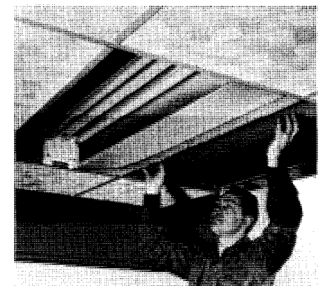
Dernière étape: glissez le panneau de défilement qui dissimule les lampes fluorescentes et qui laisse filtrer la lumière. Il s'en vend des translucents à lames et à alvéoles.
