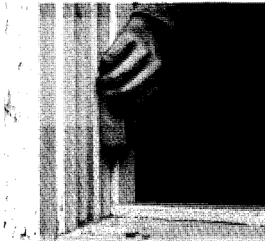
Poncez les arêtes des séparateurs du guide intérieur et du guide borgne dont la peinture a été grattée.
