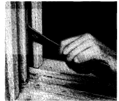
Si ces moyens sont inefficaces, enlevez le guide intérieur d'un côté pour démonter le châssis inférieur.
