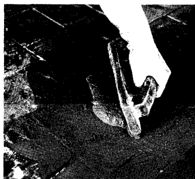
Laissez reposer les carreaux pendant une nuit; remplissez les joints de coulis.
